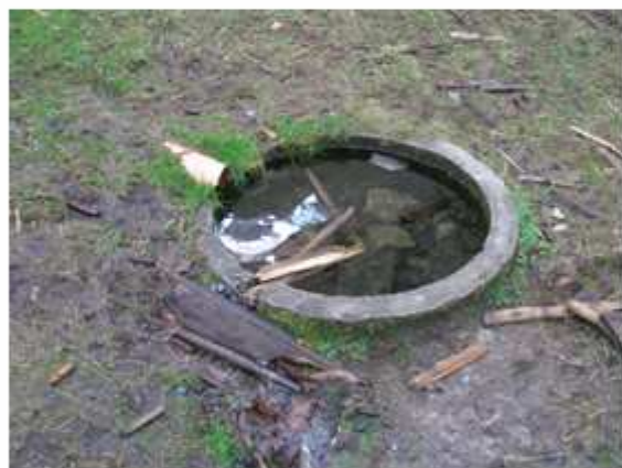
Vlevo: Původní stav vodního zdroje Vpravo: Pramen po revitalizaci
